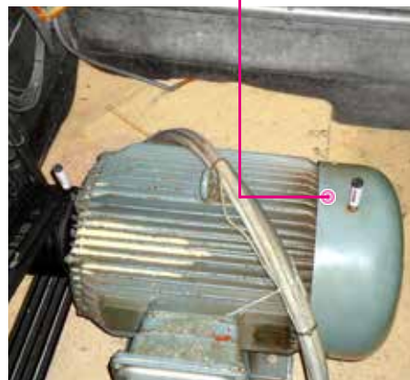
De elektromotor van een hakselmachine in een zagerij wordt gesmeerd.
