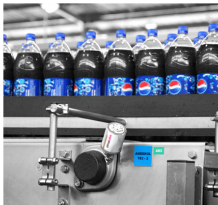
Schmierung eines Flanschagers bei einer Abfüllanlage für Soft-Drinks.
