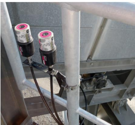
Die Schmierpunkte befinden sich in gefährlicher Höhe. Zwei simalube IMPULSE sind an einem leicht zugänglichen Ort montiert. Der Schmierstoff wird dem Lager über eine Schlauchleitung zugeführt.
