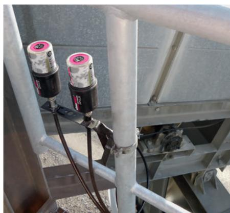
Les points de graissage se trouvent à une hauteur dangereuse. Deux simalube IMPULSE sont montés dans un endroit facilement accessible. La graisse est amenée au palier par le biais d'un tuyau souple.
