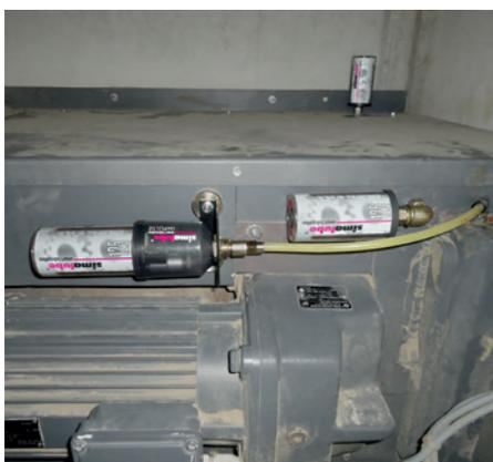
La graisse est amenée au point de graissage par le biais d'une longue conduite. Un support de montage muni de deux aimants fixe le simalube IMPULSE à l'installation.
